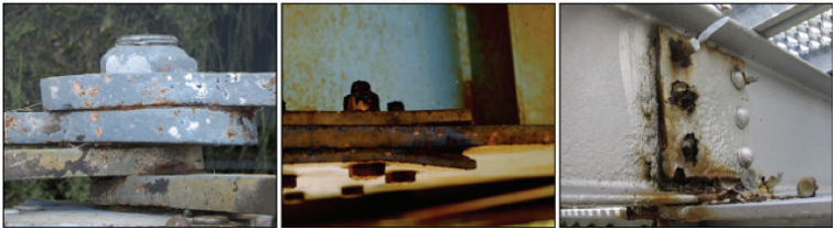
Gambar C.20 Ilustrasi kode kerusakan 308 Sambungan yang longgar, dari kiri ke kanan kehilangan kekencangan bertambah parah dan/atau volume semakin meluas (Wisconsin DOT, 2020)
