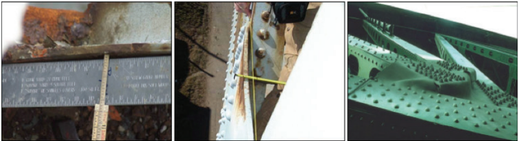
Gambar C.16 Ilustrasi kode kerusakan 303 Perubahan bentuk pada komponen, dari kiri ke kanan kerusakan distorsi bertambah parah dan/atau volume semakin meluas (Wisconsin DOT, 2020)
