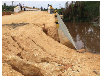
522 Penurunan-Tanah Timbunan
