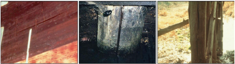
Gambar C.24 Ilustrasi kode kerusakan 402 Komponen yang rusak atau hilang (termasuk retak, delaminasi), dari kiri ke kanan delaminasi bertambah parah dan/atau volume semakin meluas (Wisconsin DOT, 2020)
