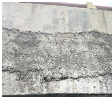
Gambar C.4 Ilustrasi kode kerusakan 201 Cacat pada beton termasuk beton rontok/ spalling , keropos, berongga, dan kualitas beton yang rendah
