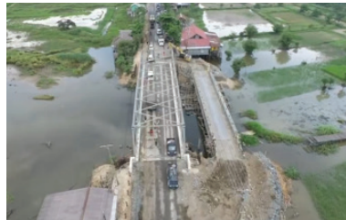
504 Air sungai macet yang mengakibatkan terjadinya banjir ( excess afflux )
