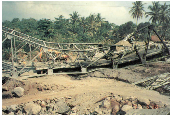
Gambar C.18 Ilustrasi kode kerusakan 303 Perubahan bentuk pada komponen secara keseluruhan akibat kebakaran
