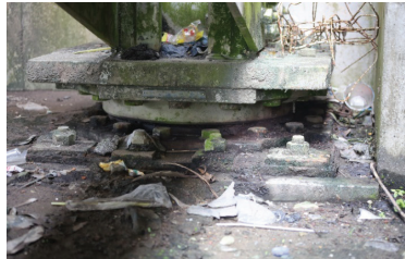
607 Kurangnya pelumasan pada landasan logam
