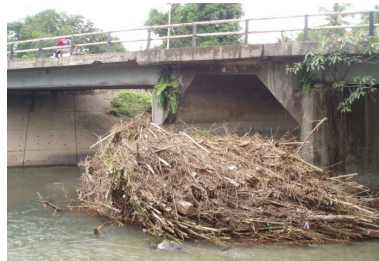
502 Penumpukan debris dan hambatan aliran sungai
