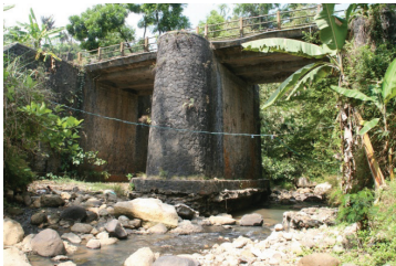
503 Penggikisan di sepanjang aliran sungai ( contraction scour )
