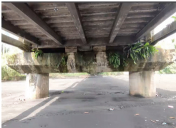
501 Pendangkalan sungai akibat endapan* (agradasi) akibat akumulasi material gunung berapi
