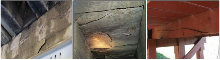
Gambar C.23 Ilustrasi kode kerusakan 402 Komponen yang rusak atau hilang (termasuk retak, delaminasi), dari kiri ke kanan retak bertambah parah dan/atau volume semakin meluas (Wisconsin DOT, 2020)
