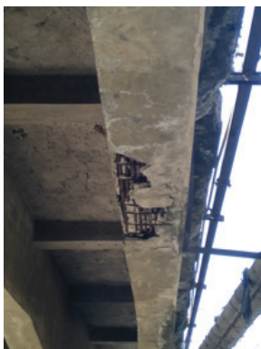
Gambar C.4 Ilustrasi kode kerusakan 201 Cacat pada beton termasuk beton rontok/ spalling , keropos, berongga, dan kualitas beton yang rendah
